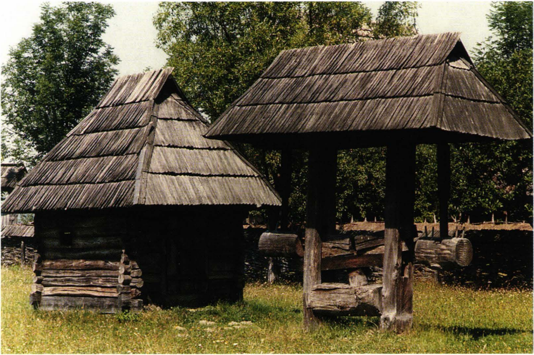
Ölmühle mit Rammklötzen und Getreidetrockner - Breb
